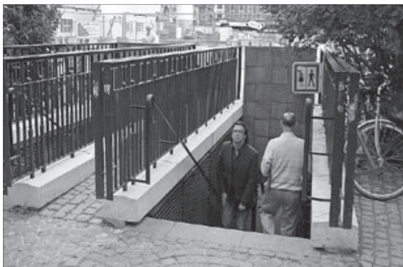
Zoals in elke zichzelf respecterende stad hebben ze het in Straatsburg ook begrepen: openbare toiletten zijn onontbeerlijk! Die op de foto zijn net opgeleverd.
